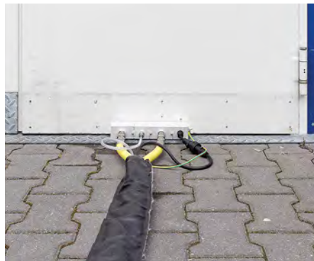
PlanoPT también se puede emplear en la instalación debajo de puertas de protección contra incendios, lo cual resulta óptimo, por ejemplo, en la climatización de naves.
